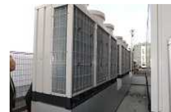
損傷・異音・異常振動の有無の確認
