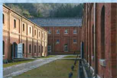
舞鶴 赤煉瓦倉庫
