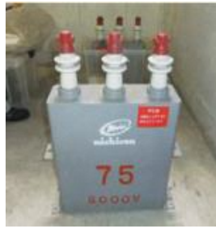
電力用コンデンサー
