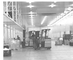
冷凍冷蔵設備
