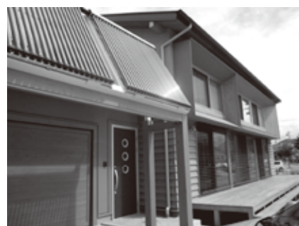
ゼロ・エネ住宅(手前は太陽熱給湯システム)
