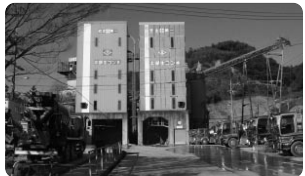
生コンプラント工場
