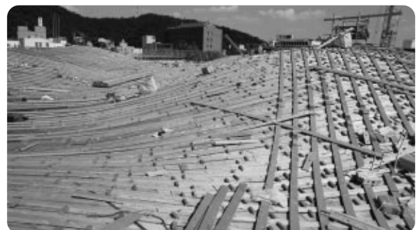
県産桧を使用した岐阜市新図書館の屋根工事状況
